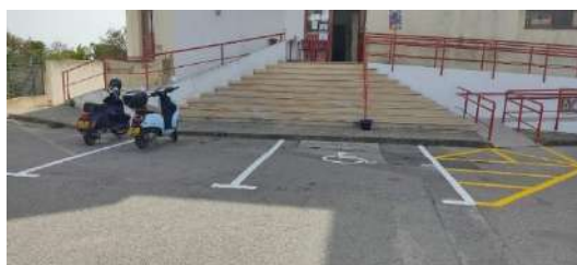
Pintura de listas amarelas e espaço para pessoas com mobilidade reduzida no Centro Comunitário de Alvor.
