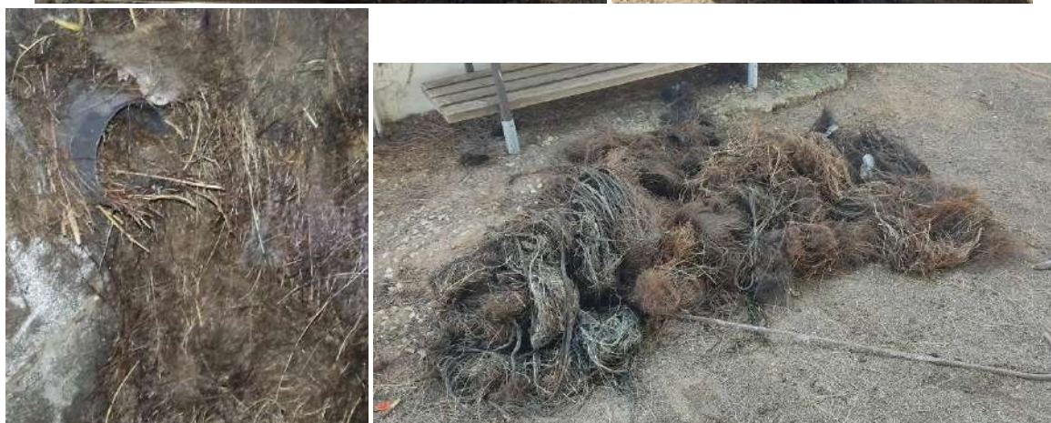
Retirada de raízes de caixa de esgoto no Grupo Desportivo e Recreativo Alvoreense.
