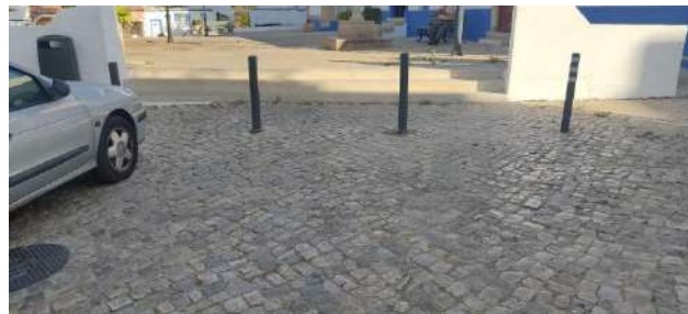
Reforço de pinos na entrada da Igreja do Divino Salvador.
