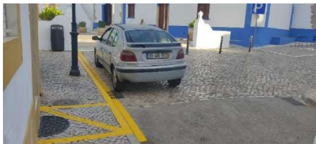
Pintura de listas amarelas na Rua 25 de Abril.
