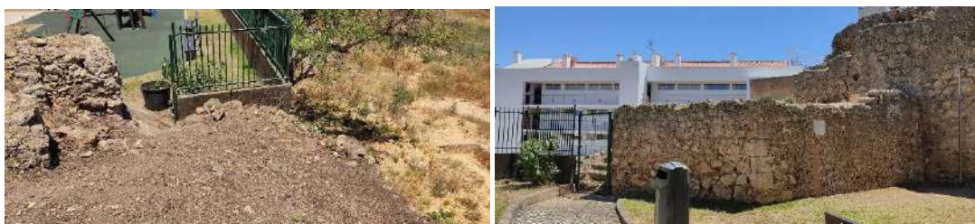
Limpeza da Muralha do Parque Infantil do Castelo.
