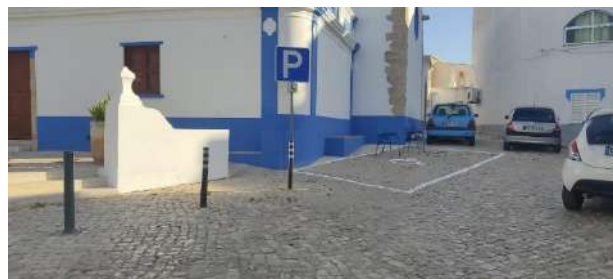
Pintura das linhas de lugar de estacionamento para Pessoas com Mobilidade reduzida.
